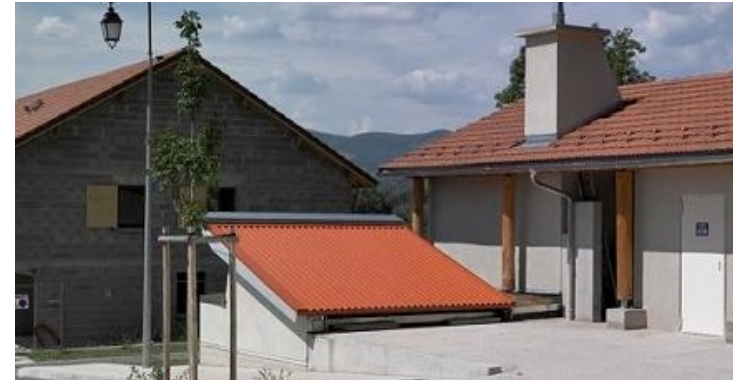
Chaufferie bois La Rivière (38)
